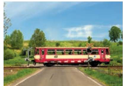
Neu gesicherter Bahnübergang an der Strecke Rakovník – Bečov nad Teplou mit der Bahnübergangssicherungsanlage PZZ-RE von AŽD.
